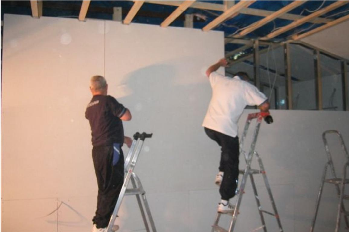
Beplanken der Innenwände und Decken mit Gipskarton
