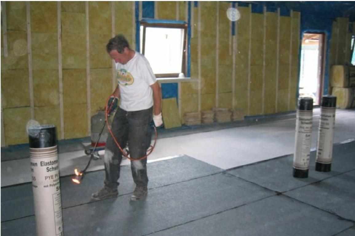
Einfache Dämmung im Trockenbau / Verlegen der Bitumenbahnen
