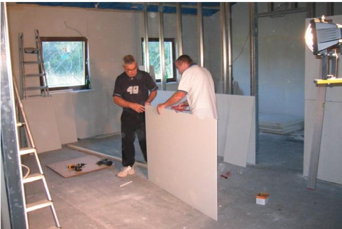
Einfache Eigenleistung: Beplanken der Wände mit Gipskarton
